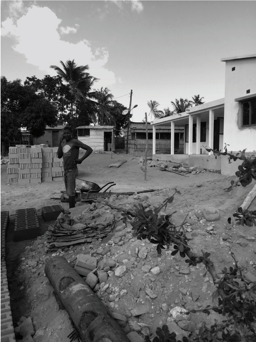
Fig. 1 — Une zone périurbaine en plein essor, Inhambane.
