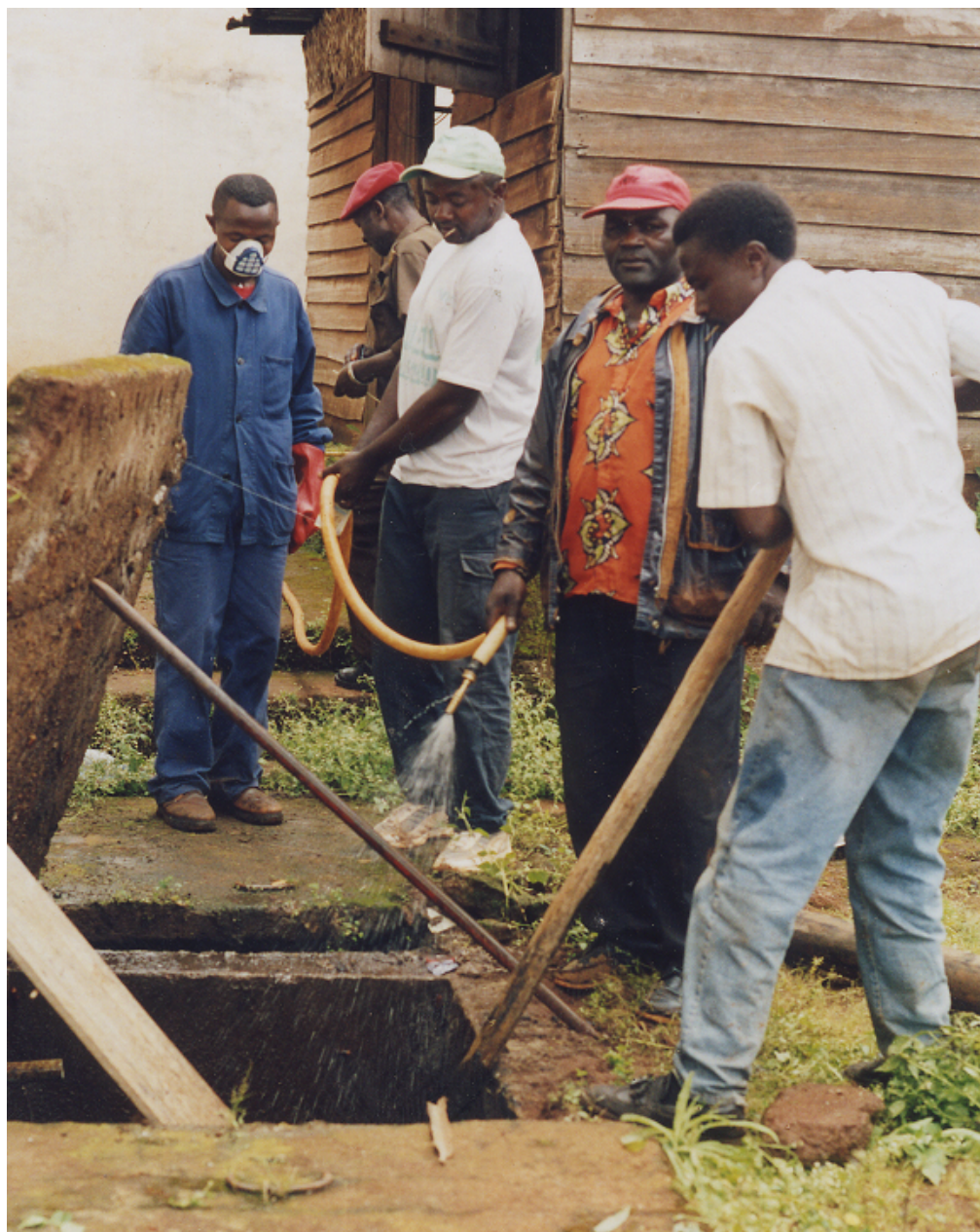
Figure 4. Séance de dilution des boues de vidange d'une fosse septique /Diluting the faecal sludge of a septic tank before emptying.
