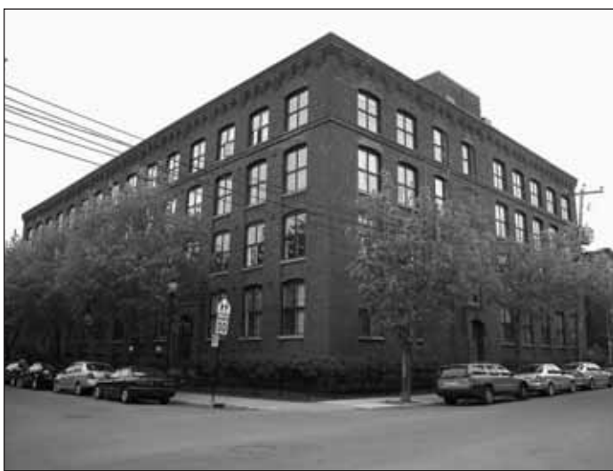
Une ancienne manufacture, rue Demers dans le quartier Plateau-Mont-Royal, est aujourd'hui convertie en immeuble en copropriété.
