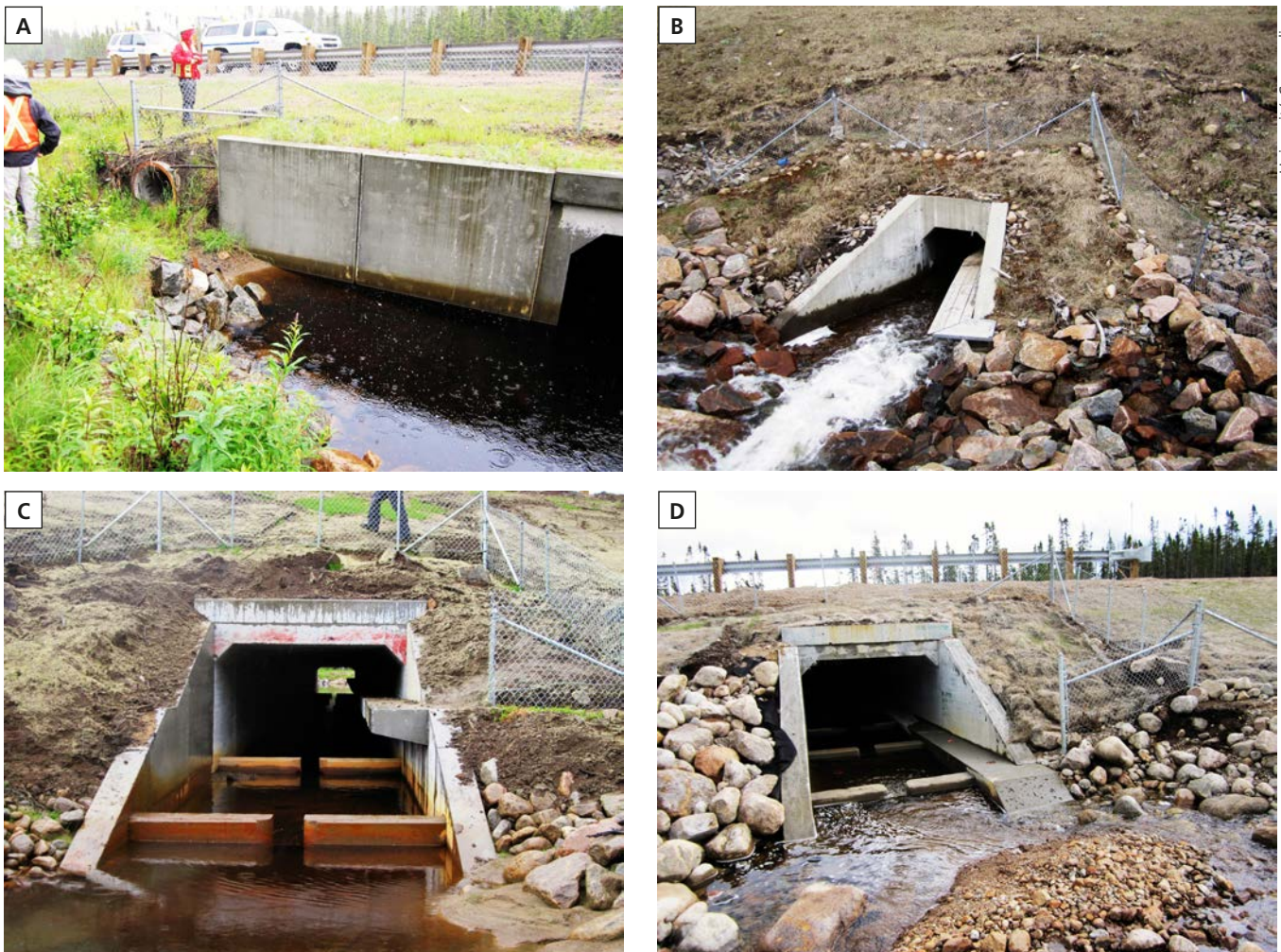
Figure 2. Quatre types de passages fauniques conçus pour les mammifères de petite et de moyenne taille le long de la route 175 : (a) ponceau sec (PS) ou tuyau circulaire ( n = 6 ); (b) ponceau avec tablette de bois installée en porte-à-faux (PTBois) ( n = 4 ); (c) ponceau avec pied sec de type tablette de béton (PTBét) ( n = 7 ); (d) ponceau avec banquette de béton (PBBét) ( n = 1 ).
