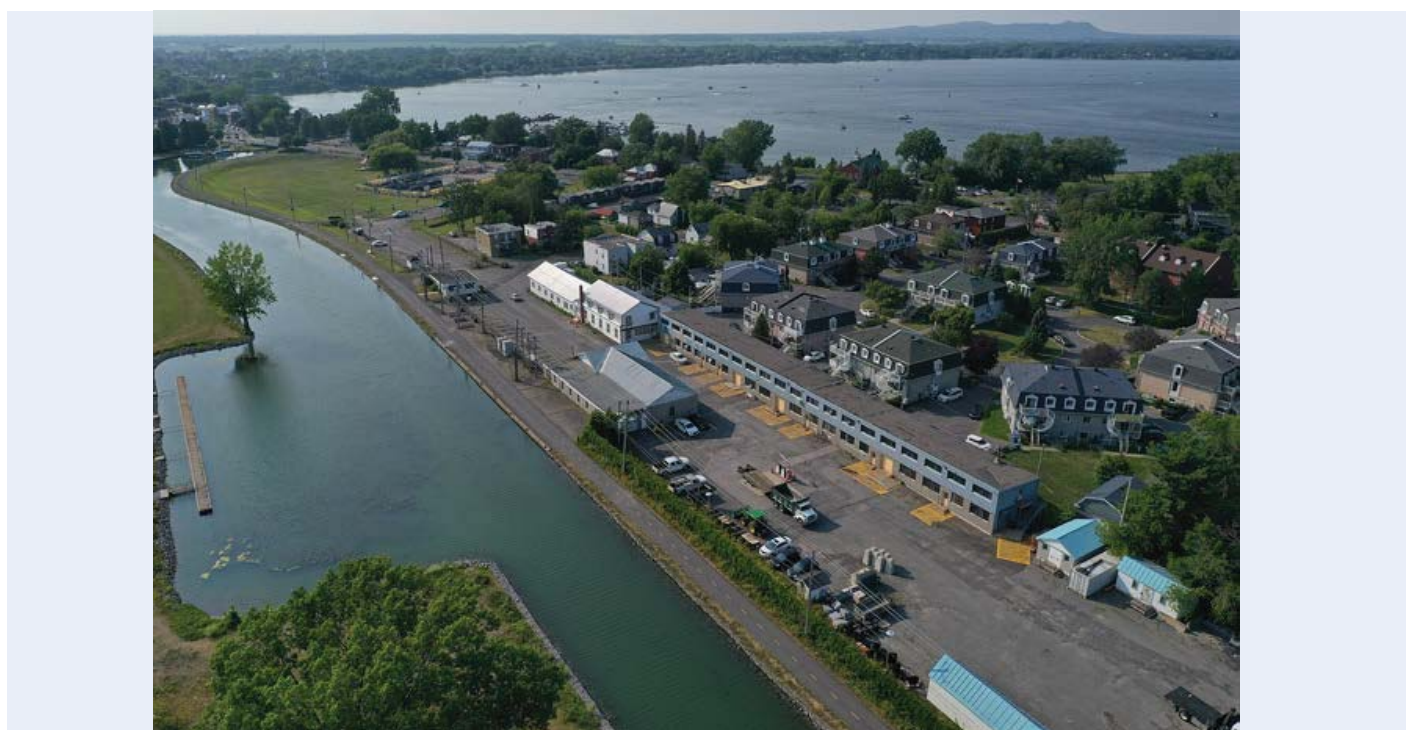
Figure 10 - 2019 – Vue aérienne du canal de Chambly et du secteur des ateliers (secteur Chambly). Crédit : Parcs Canada.
