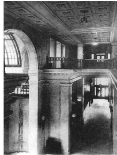
Carrère et Hastings; E. G. Bird, associé (Ross et MacFarlane, associés). Édifice Transportation, Montréal, 1909-1912. Démoli. Corridor.
