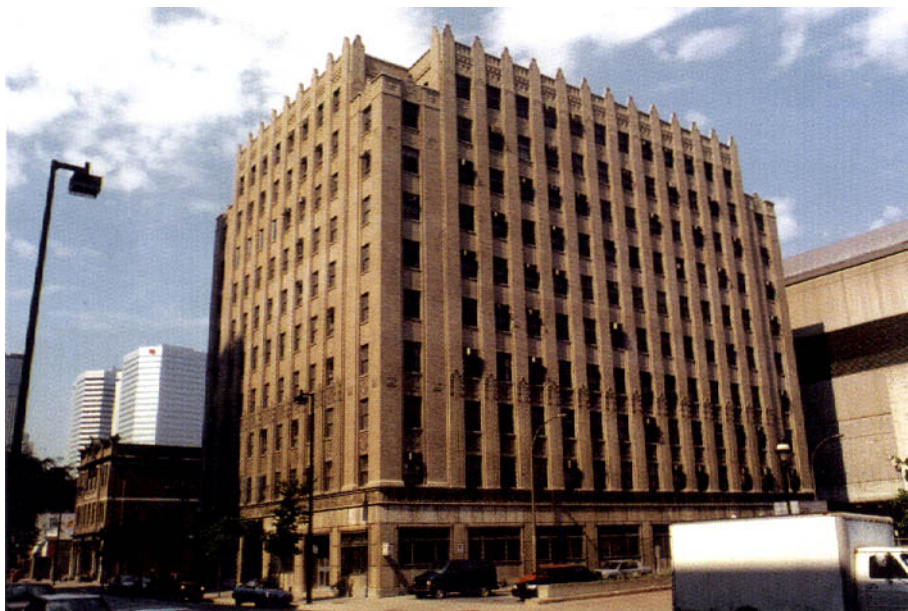
Ross et Macdonald, édifice Tramways , Montréal, rue Saint-Antoine Ouest, 1927-1930. Photographie : J.L., 1999.
