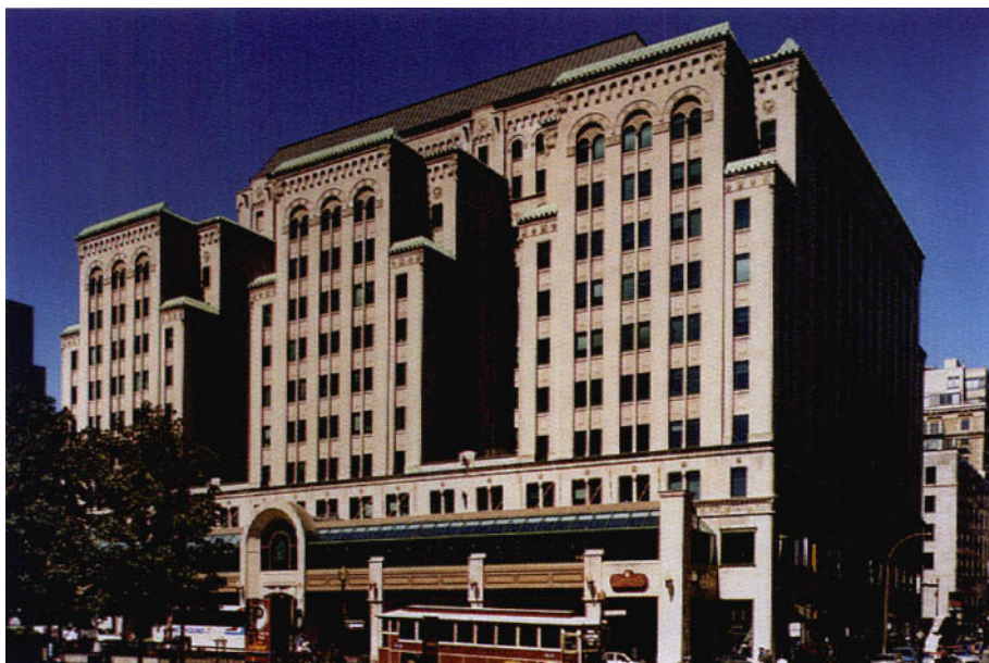
Ross et Macdonald. Édifce Dominion Square, Montréal, rue Sainte-Catherine Ouest, au coin de la rue Peel, 1928-1940. Extérieur, élévation arrière. La partie inférieure a été agrandie. Photographie: J.L., 1999.
