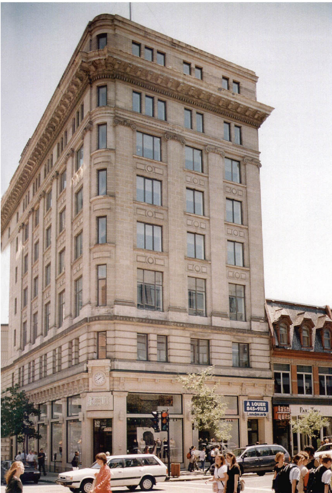
Ross et MacFarlane. Édifice Willis, Montréal, rue Sainte-Catherine Ouest, au coin de la rue Drummond, 1910; agrandissement latéral en 1926-1927. Photographie: J.L., 1999.
