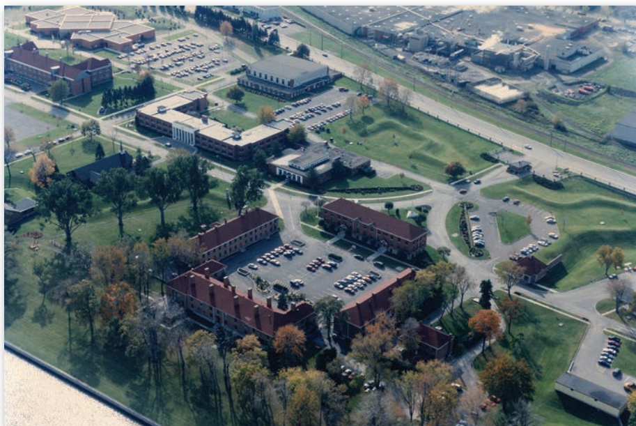
Vue aérienne du Collège militaire royal de Saint-Jean, 1994. (Source : Musée du Fort Saint-Jean, MFSJ19940300003)
