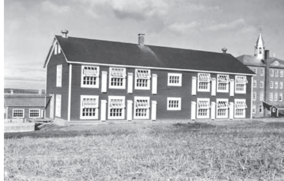
Nouveau poulailler avec l'éleveuse rehaussée sur deux étages, 1954.
