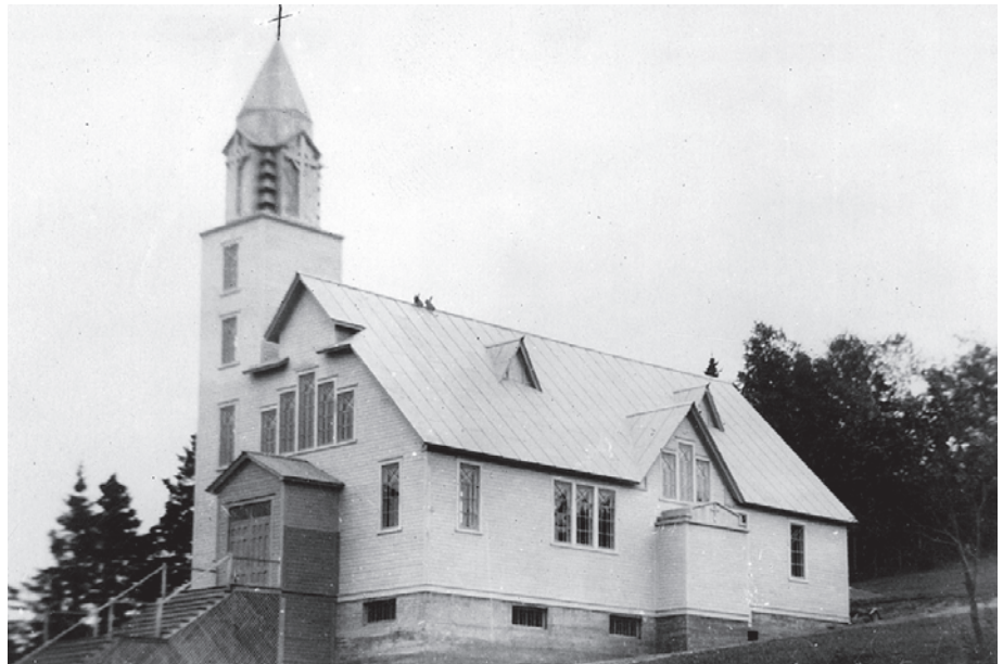
Le sanctuaire de Pointe-Navarre.
