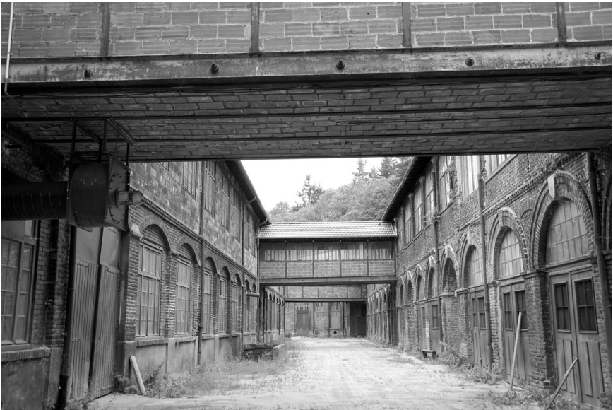
Figure 2 : Pont-Salomon, site Alliance, rue intérieure. Photo J. Garleff 2020.
