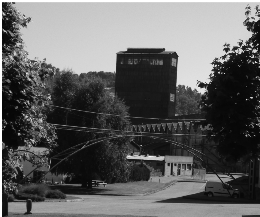
Figure 4. Tour de Trempe (Firminy). Ancienne tour de trempe des aciéries et forges de Firminy, réutilisée par une entreprise de métallurgie. © Luc Rojas
