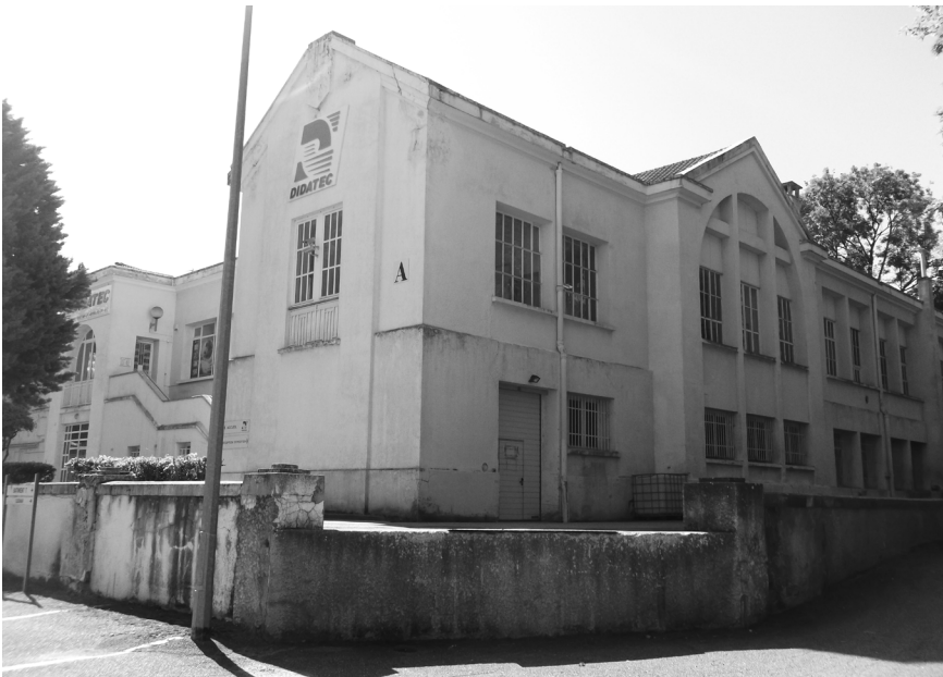
Figure 6. Ancien laboratoire des entreprises métallurgiques Holtzer (Fraisses). Ce bâtiment abrite aujourd'hui une entreprise de papeterie. Il est inclus dans un parc d'activité qui réutilise les anciens bâtiments industriels édifiés par Holtzer. © Luc Rojas
