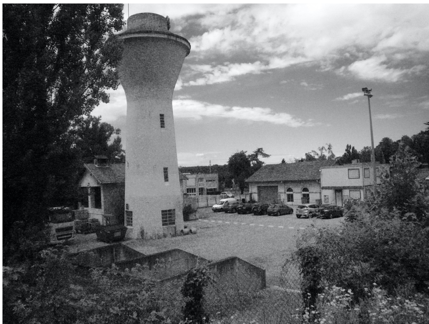
Figure 1. Ce qui reste du « plâtre » (terme désignant les installations de surface dans le vocabulaire utilisé dans le bassin houiller de la Loire) du puits Saint-Joseph sur la zone industrielle de Molina La Chazotte à l'est de Saint-Étienne : le château d'eau qui masque partiellement le bâtiment des chaudières, à droite le bâtiment des ventilateurs et des bureaux sont actuellement occupés par une grande société de travaux publics qui a absorbé l'entreprise locale de maçonnerie qui en était le premier utilisateur. © Georges Gay
