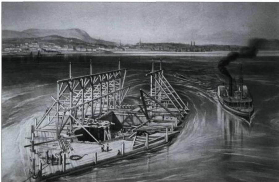
*Pour réaliser les piliers du pont Victoria, on construit des caissons en bois dans lesquels seront insérés les blocs de pierre qui formeront les piliers.*
