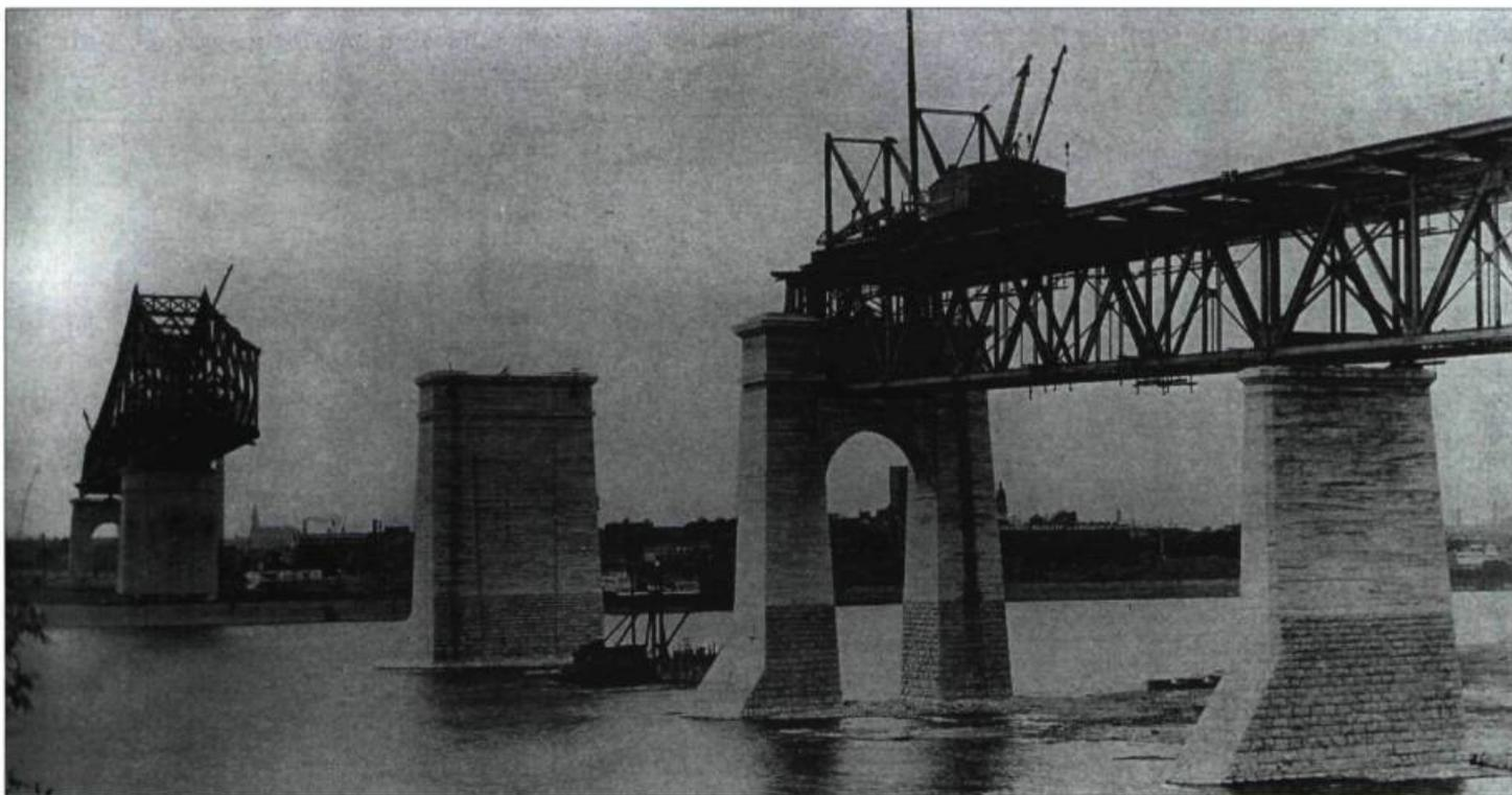
Depuis le pont Victoria, la technologie a évolué. Pour les piliers du pont Jacques-Cartier, on utilise du béton coulé dans des formes hors terre. Pour planter ces piliers dans l'eau, il faut creuser le lit du fleuve en cale sèche et faire des fondations. On installe donc des caissons vis-à-vis de l'endroit des piliers, on les descend jusqu'au fond du fleuve et on les vide de leur eau. Des compresseurs sont installés afin d'équilibrer les pressions interne et externe.
