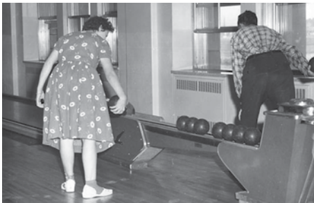
Figure 4: P1 304 – S01 – P07 Bowling au rez-de-chaussée C-01, [après 1959]
