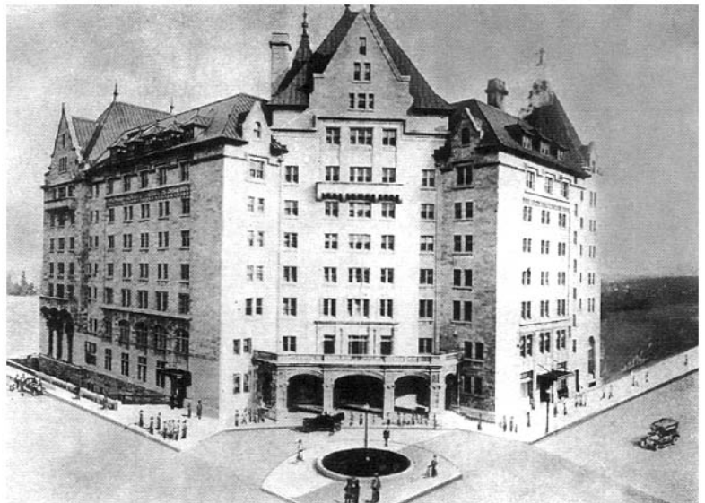
Ross et Macdonald. Hôtel Macdonald, Edmonton, 10 th Street, 1912-1914. Façades principales. Photographie tirée de Construction, mai 1916.
