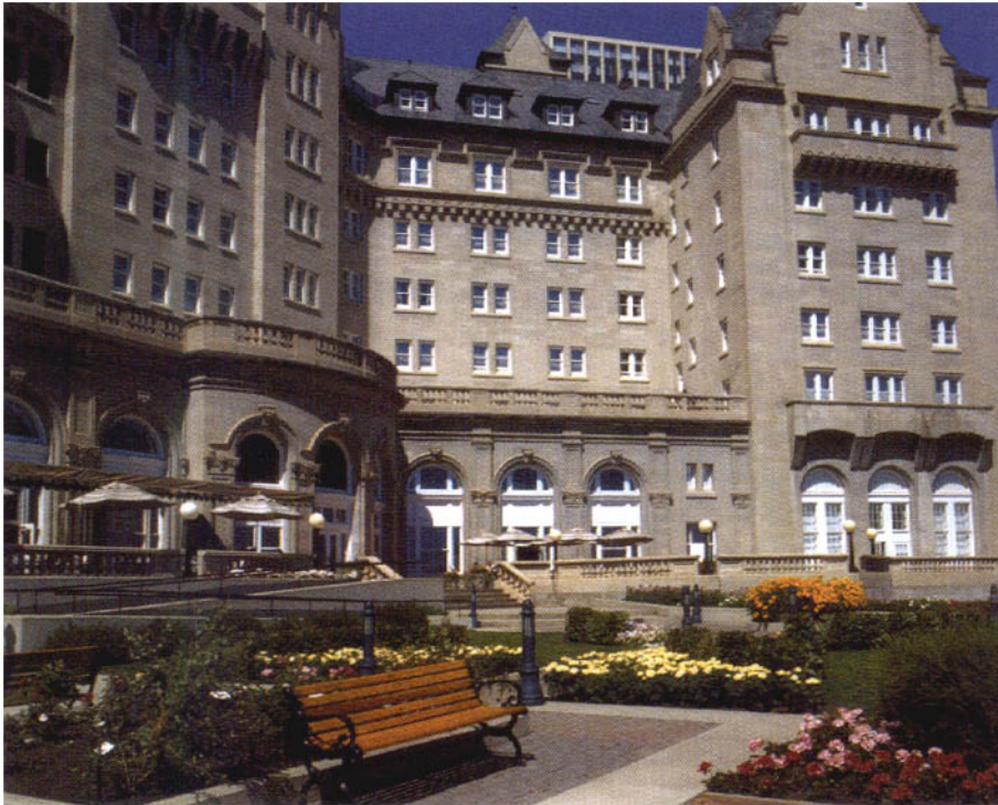
Ross et Macdonald. Hôtel Macdonald, Edmonton, 1912-1914. Façade arrière. Photographie : Hôtel Macdonald, Canadien Pacifique.
