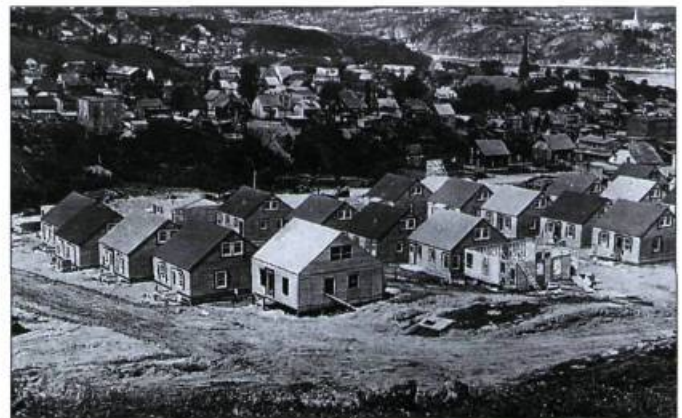
Maisons de la Wartime Housing Limited à Chicoutimi, projet de 1943. Photo : Archives nationales du Canada.
