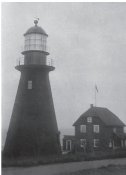
Phare de La Martre en 1934. À noter la maison avec la cheminée à l'intérieur. Elle brûla l'année suivante en 1935.
