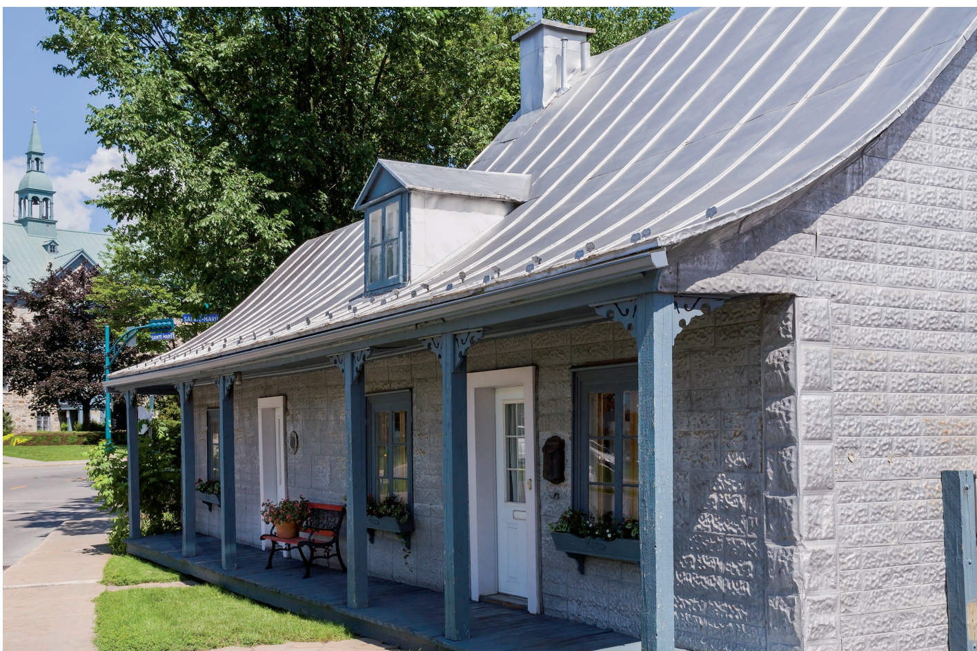
Clouées sur les murs existants, les feuilles de tôle embossée peuvent arborer différents motifs.
