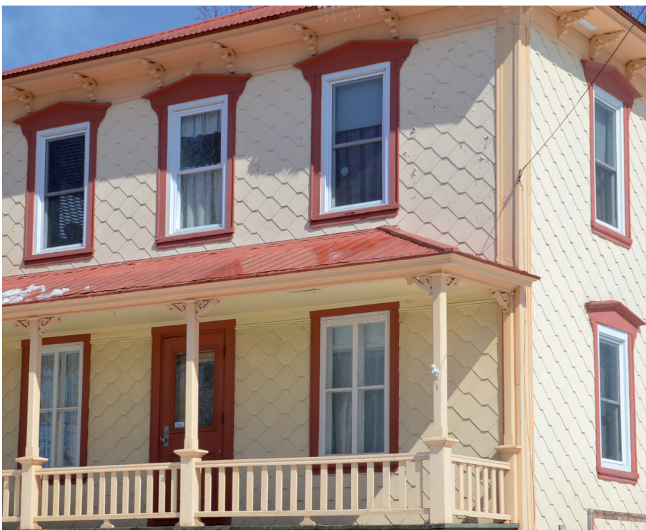
Dans les années 1920 à 1950, les tuiles d'amiante-ciment séduisent, car en plus de résister au feu, elles sont jolies, peu coûteuses et faciles à entretenir.
