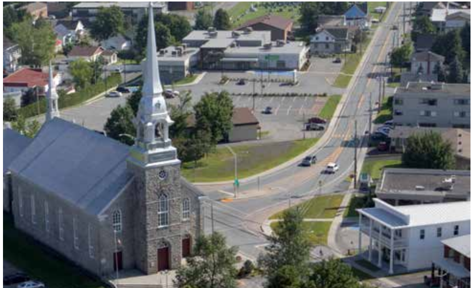
Le cœur du village de Saint-Éphrem-de-Beauce en 1955 (en haut) et après la démolition de l'ancien magasin général Lucien-Bolduc, en 2009.
