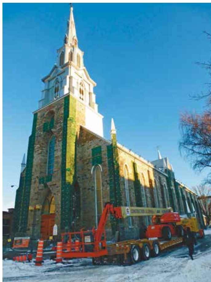
En 2014, on a érigé un périmètre de sécurité autour de la cathédrale et posé des filets de rétention sur le bâtiment.
