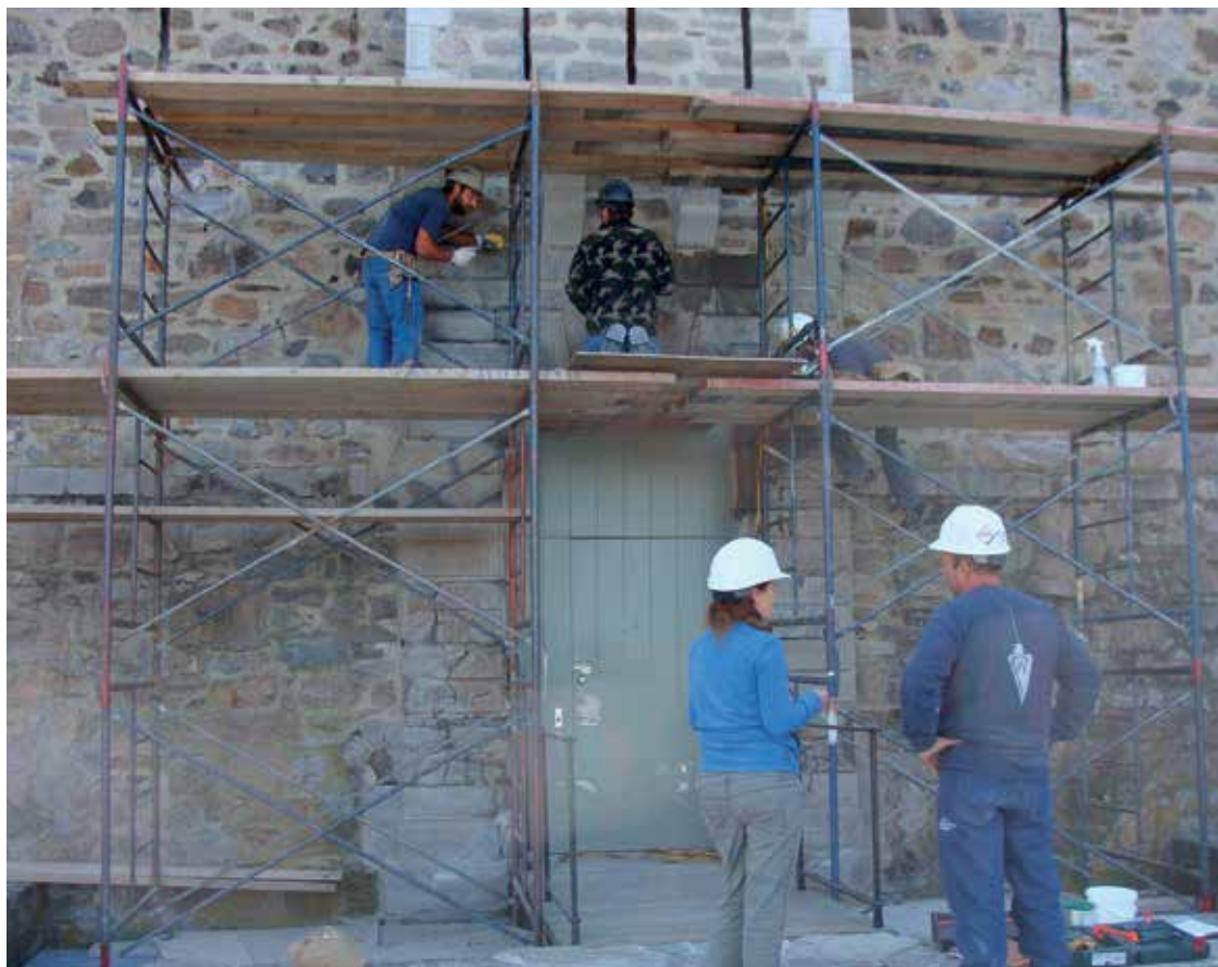
Pour leurs interventions sur de la maçonnerie ancienne, les restaurateurs font parfois appel à l'expertise de tailleurs de pierre. Photo: Mathieu Carpentier
