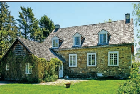
L'une des rares maisons de ferme en pierre conservées sur le territoire de Beaconsfield-Baie-D'Urfé, cette résidence construite en 1830 compte parmi les lauréates de 2005.
