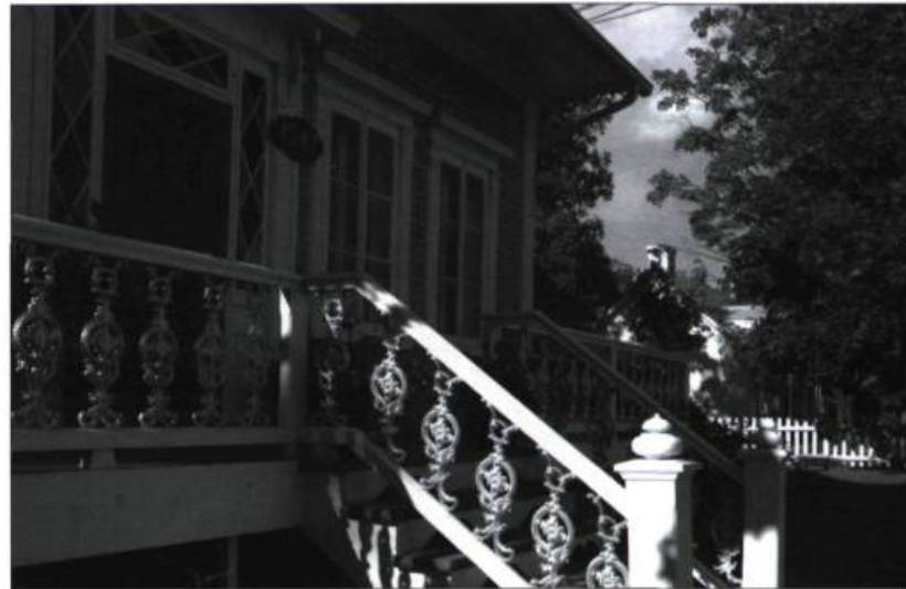
Ces balustres de fonte moulée enjolivent la devanture de la maison.
