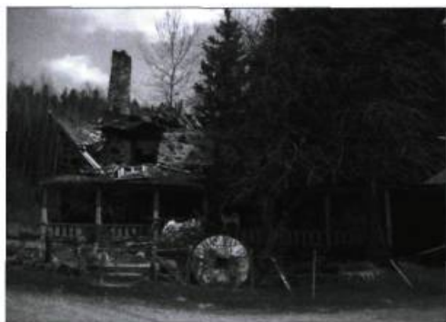
Le toit du moulin du Gouffre de Baie-Saint-Paul s'est effondré l'an dernier.
