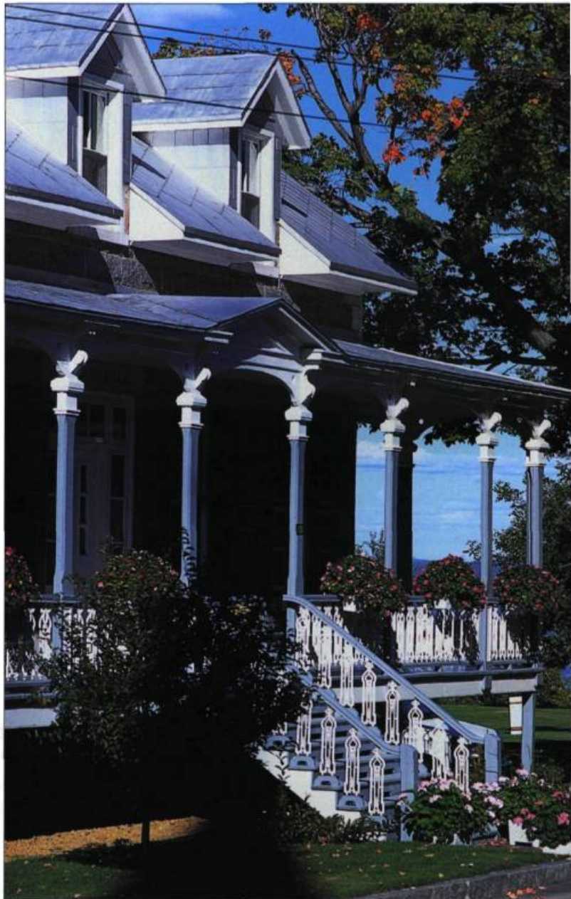
Le presbytère de Deschambault, devenu l'hôtel de ville de Deschambault-Grondines, comporte un escalier joliment orné de balustres de fonte.
