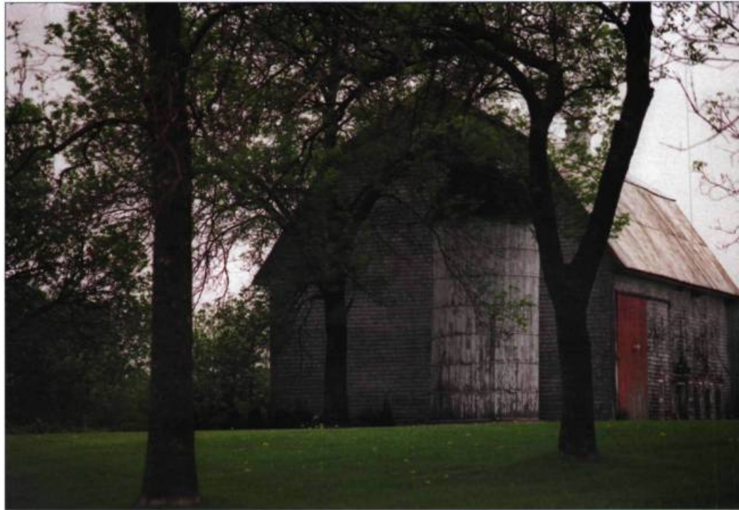
Certains ensembles agricoles de la région de Lotbinière recèlent de petits trésors architecturaux, tel ce silo de bois d'une grange de Saint-Gilles.
