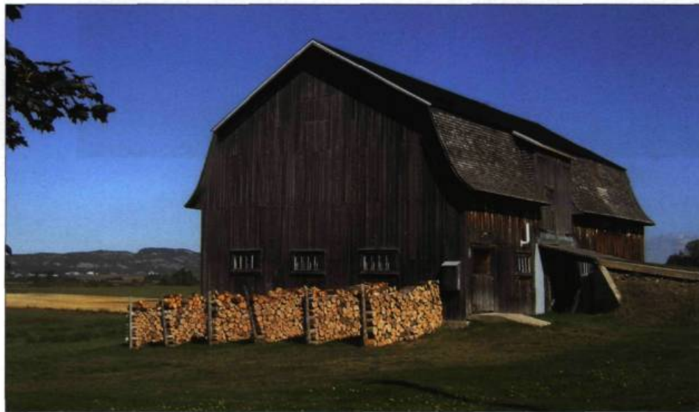
Avec ses deux étages, son fenil au-dessus de l'étable et son toit mansardé, cette grange du Kamouraska représente le bâtiment agricole québécois typique du milieu du XX e siècle, avant l'intensification de l'agriculture.
