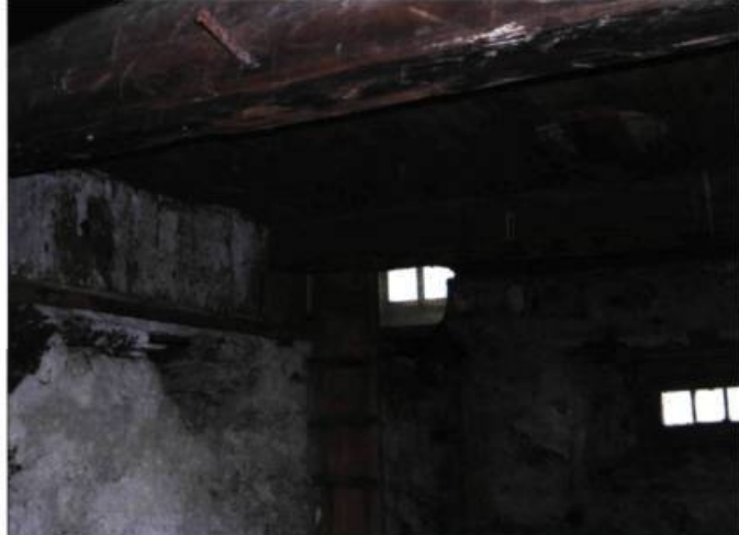
L'observation des poutres et des solives du plancher du rez-de-chaussée permet de déterminer avec quels outils le bois a été taillé. Avant 1870, on utilisait la hache, l'herminette ou la scie verticale pour tailler les pièces de bois.
