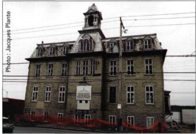
Photo: Jacques Plante Les travaux de restauration ont peu modifié l'enveloppe extérieure du Vieux-Couvent. Toutefois, la maçonnerie, la tôle et les boiseries ont exigé d'importantes réparations.
