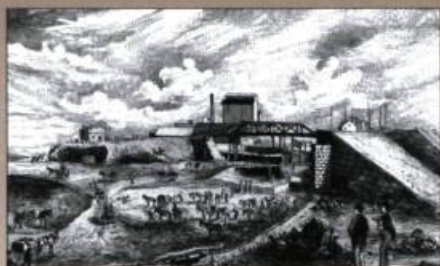
Les travaux d'agrandissement du canal de Lachine en 1874.
