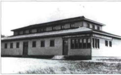
Le Frigidaire tel qu'on pouvait le voir en 1932 avant les agrandissements majeurs.
