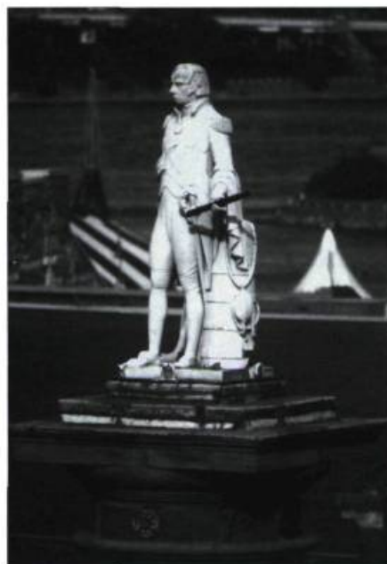
La technique avant-gardiste de moulage de pierre artificielle utilisée pour le monument de l'amiral Horatio Nelson a nui à long terme à la conservation de l'œuvre. Elle pose un sérieux problème à la Ville de Montréal.
