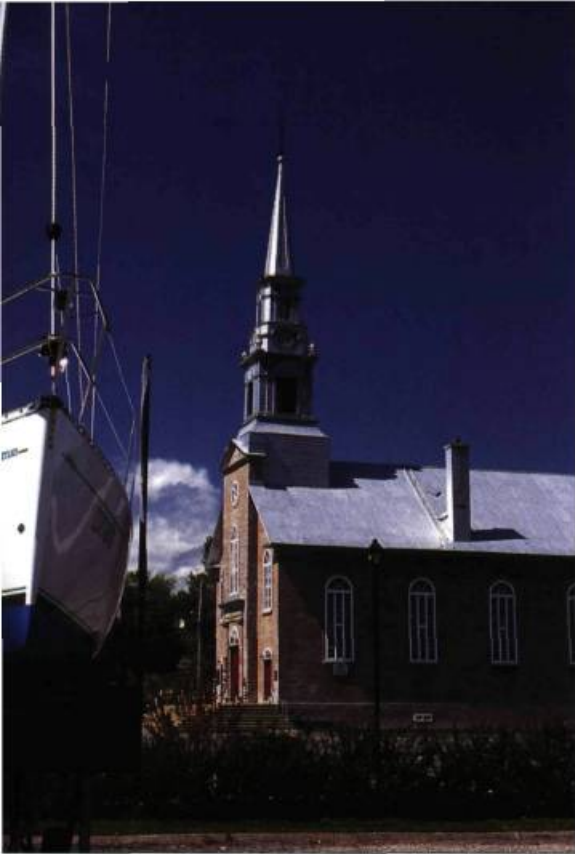
Église de Saint-Laurent, 1861. Dans la seconde moitié du XIX e siècle, chaque village possède son quai non loin de l'église paroissiale.
