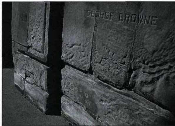
Détail de la pierre de l'ancienne banque Molson sur la rue Saint-Jacques, 1994. Photo : Dinu Bumbaru
