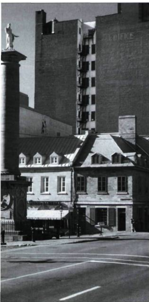
Colonne Nelson (1809) et immeubles de la même époque qui marquent l'intersection du marché Neuf (place Jacques-Cartier) et de la rue Notre-Dame.
