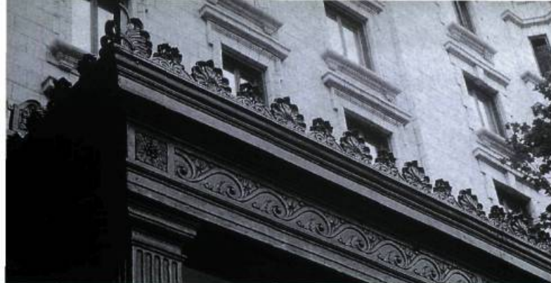
Appartements Linton : détail de la marquise qui protège les résidents de la pluie.
