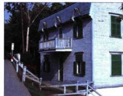
La résidence du meunier été construite au tout début du siècle.
