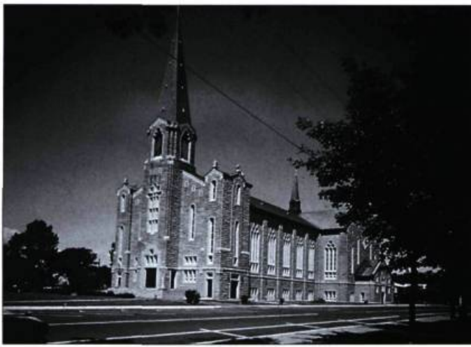
Édifiée en 1822 sur les ruines de l'église construite en 1771, l'église Saint-Thomas de Montmagny a subi de nombreuses modifications depuis sa construction. Parmi les ajouts importants, signalons les deux clochers mis en place en 1922, qui disparaîtront lors de l'incendie de 1948. L'année suivante, l'église retrouvera un clocher semblable à celui de son origine.
