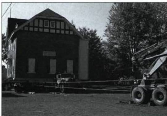
Photos : Service d'urbanisme, Ville de Québec
