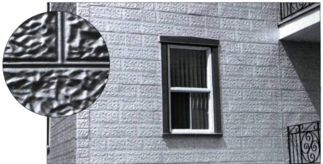
Revêtement de tôle d'origine qui imite la pierre de taille à bossage et un gros plan d'une feuille de tôle où l'on peut même voir les joints ronds en saillie.
