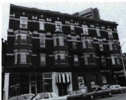
Immeuble Hanfield et Pacaud, 1124-1134, Laurier (J.-A. Godin, arch.; 1912). Photo: P.-R. Bisson et Ass.
