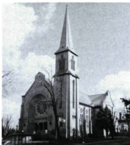
Église Saint-Germain, 696, Côte-Sainte-Catherine (David, Tourville & Perrault, arch.; 1930). Photo: P.-R. Bisson et Ass.
