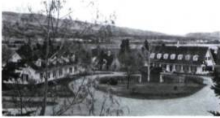
Les bâtiments de la Pisciculture de Gaspé (1938), au «cachet national canadien-français». (photo: ANQQ)
