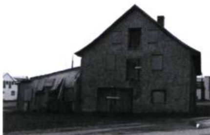
De 1988 à 1989, le site historique du Banc-de-Paspébiac a connu une cure de jouvence. La qualité de la restauration des bâtiments vaut à elle seule un détour dans ce coin de pays. (photos: Émile Gilbert, architecte)
