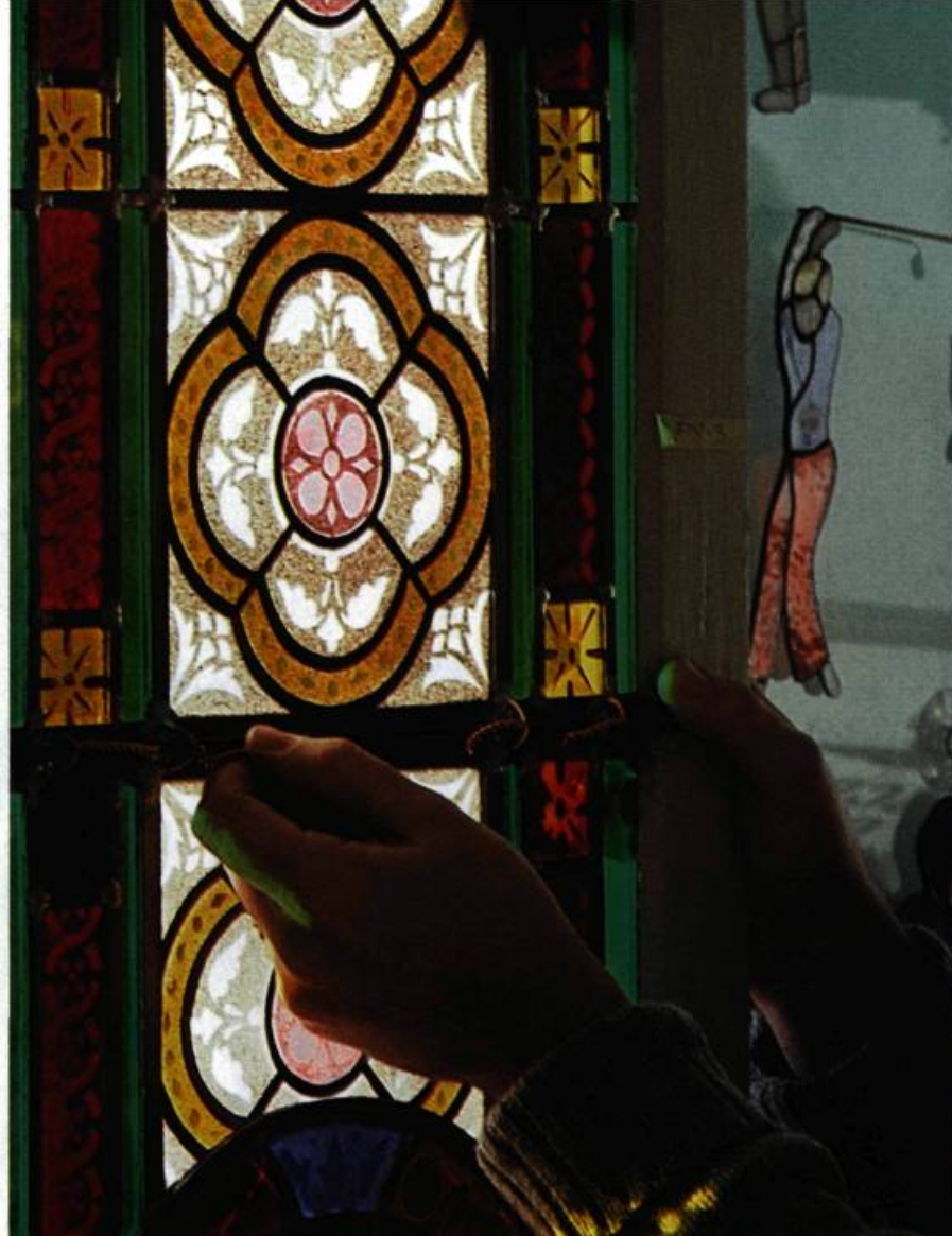
Les vergettes sont reliées aux plombs à l'aide de fils de cuivre et ancrées au cadre de la fenêtre. (photo: John Major)
