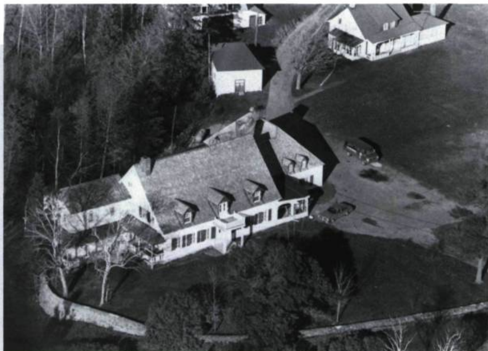
Le domaine De Sales Laterrière aux Éboulements. (photo: ministère des Affaires culturelles)
