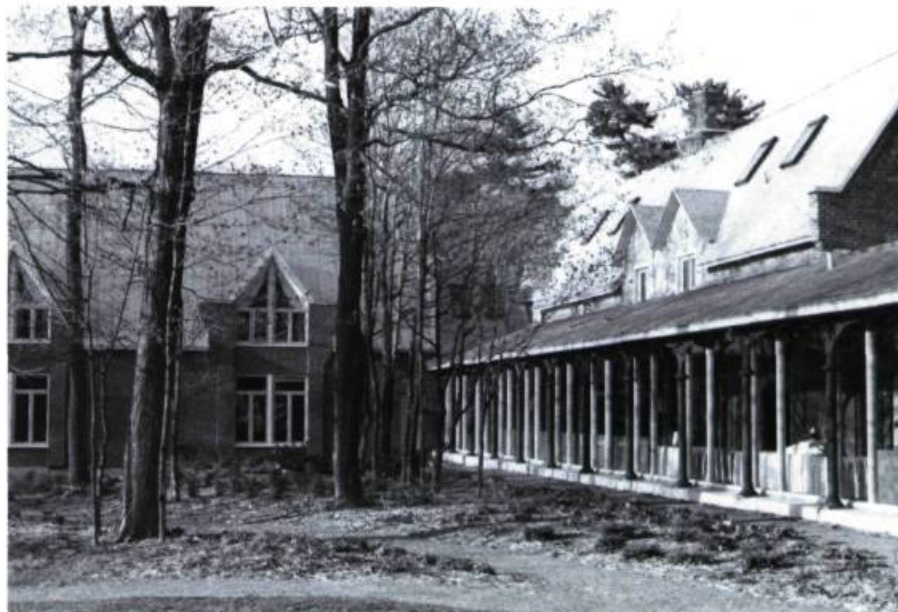
Dans les écuries, on a aménagé des cuisines et une salle à manger. Le préau, maintenant vitré, relie le manoir aux deux nouvelles ailes construites pour l'usage hôtelier. (photo: P. Trépanier)
