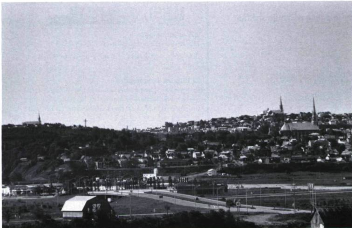
Pendant un siècle un des grands carrefour ferroviaires du Québec, Rivière-du-Loup vit maintenant au rythme de l'automobile. (photo: Formes et Paysages inc.)
