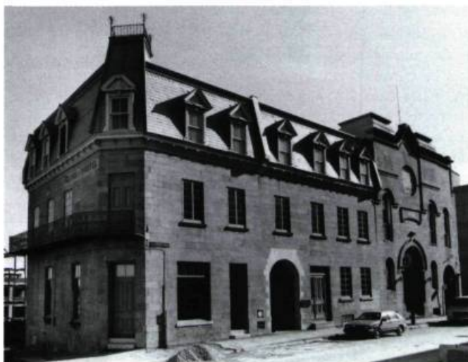
Construite entre 1836 et 1838, la maison de la rue Notre-Dame est acquise par George-Étienne Cartier en 1862. Le toit mansardé date de 1893. (photo: B. Ostiguy)
