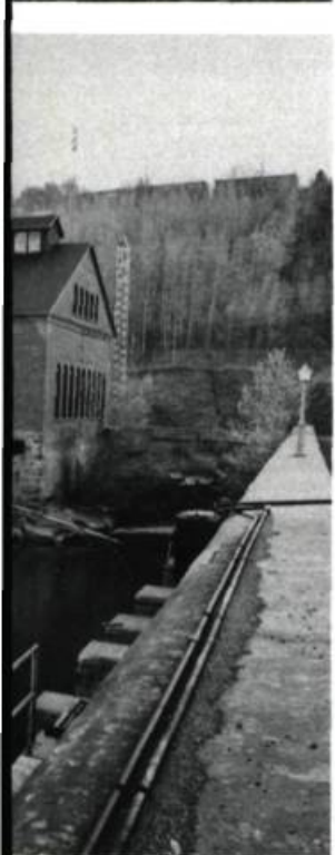
La centrale de la Northern Aluminium Company. Un édifice en brique classique et imposant construit en 1900 pour alimenter en électricité la première aluminerie canadienne. Hydro-Québec en a amorcé la restauration en 1983. (photo: Hydro-Québec)
